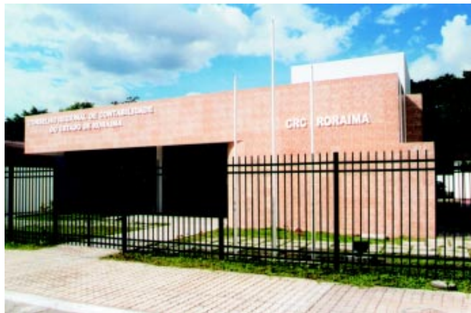
Nova sede do Conselho Regional de Contabilidade de Roraima, financiada pelo CFC
